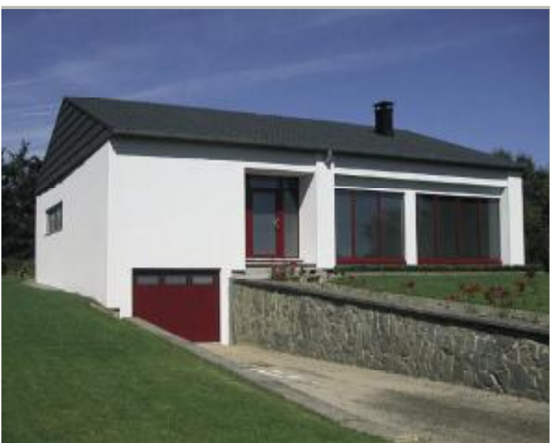
Einfamilienhaus nach der Fassadensanierung mit vinyTherm
