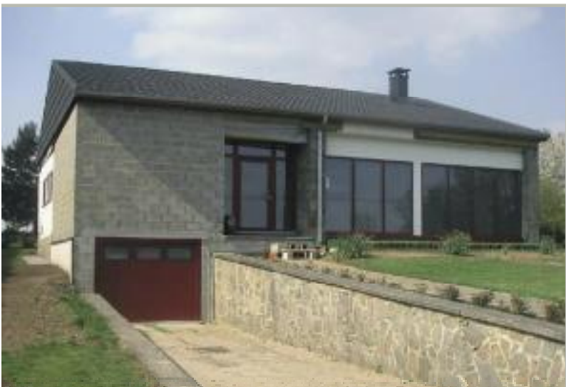
Einfamilienhaus vor der Fassadensanierung
